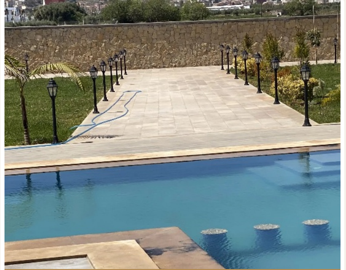
MEKNÈS - PISCINE, SOL & MUR EXTÉRIEUR
